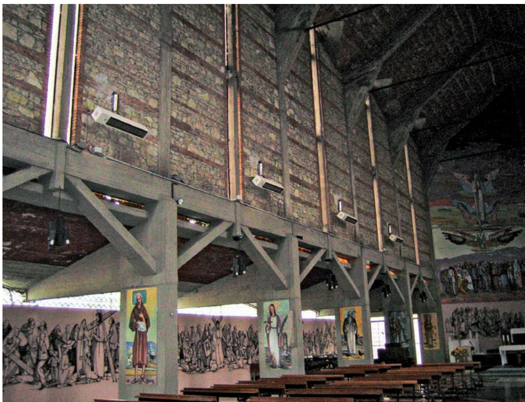
Figura 5 – A sinistra, diffusore radiante a gas sospeso nella chiesa dell'Immacolata Concezione a Terni. Sulla destra, apparato di tipo B , connesso ad una canna fumaria che espelle all'esterno i residui della combustione
