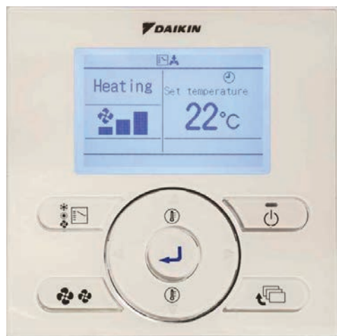
Figura 20 – Pannello comando in ambiente
