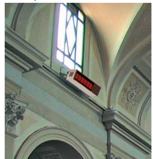
Figura 6 – Esempio di applicazione di Tipo A con diffusore installato a muro. L'espulsione dei prodotti di combustione avviene attraverso un'apertura nella finestra
