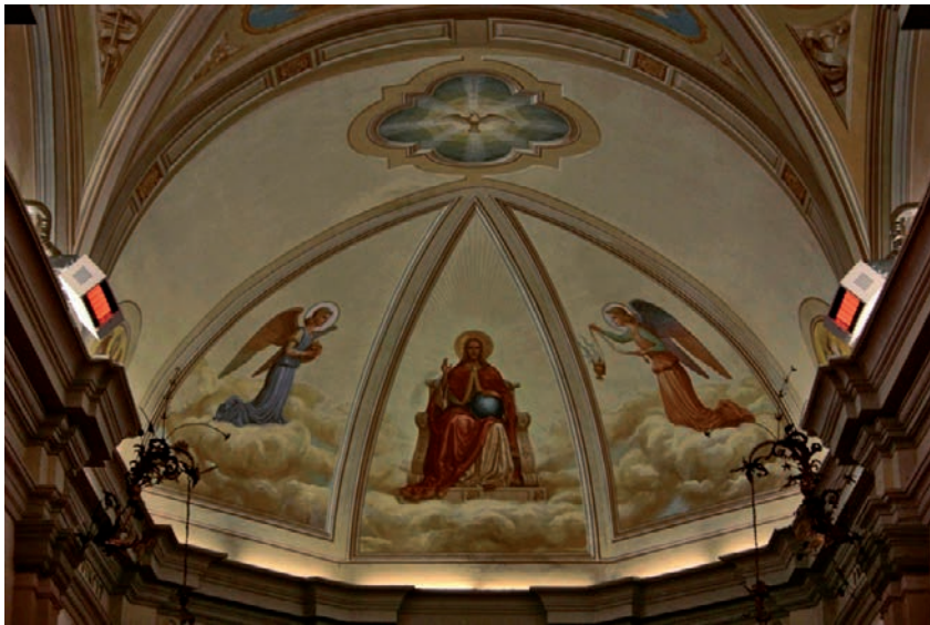
Figura 2 – Esempi di sistema radiante a gas sospeso applicati in chiese storiche
