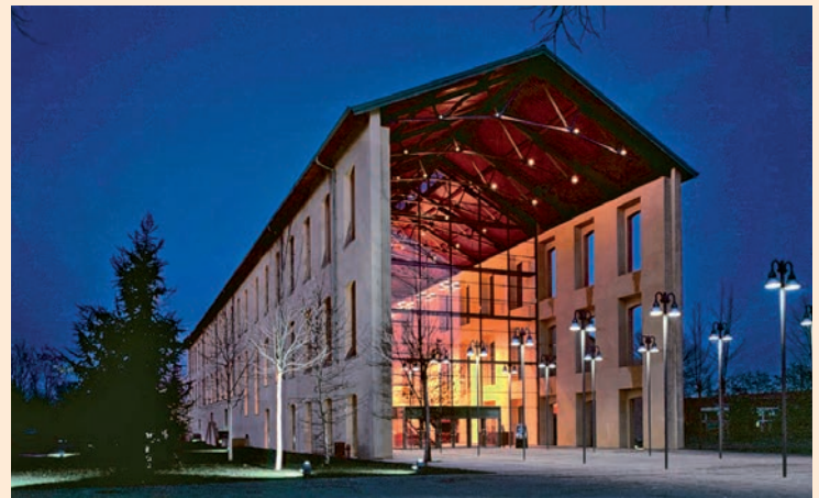
Figura 13 – Vista esterna dell'Auditorium Paganini, Parma
