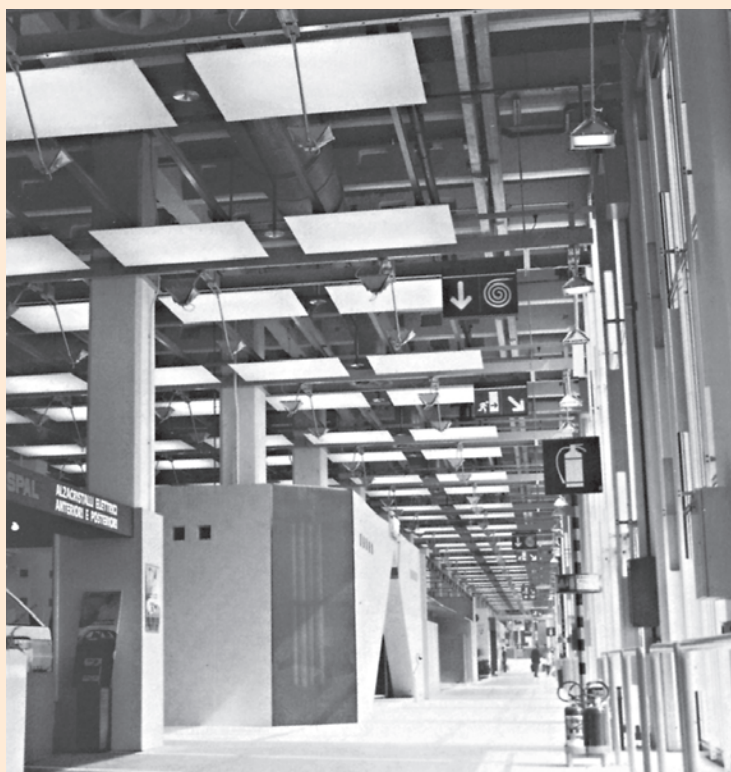
Figura 16 – Diffusori a geometria variabile per il Lingotto, Torino
