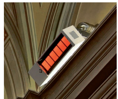
Figura 5 – A sinistra, diffusore radiante a gas sospeso nella chiesa dell'Immacolata Concezione a Terni. Sulla destra, apparato di tipo B , connesso ad una canna fumaria che espelle all'esterno i residui della combustione
