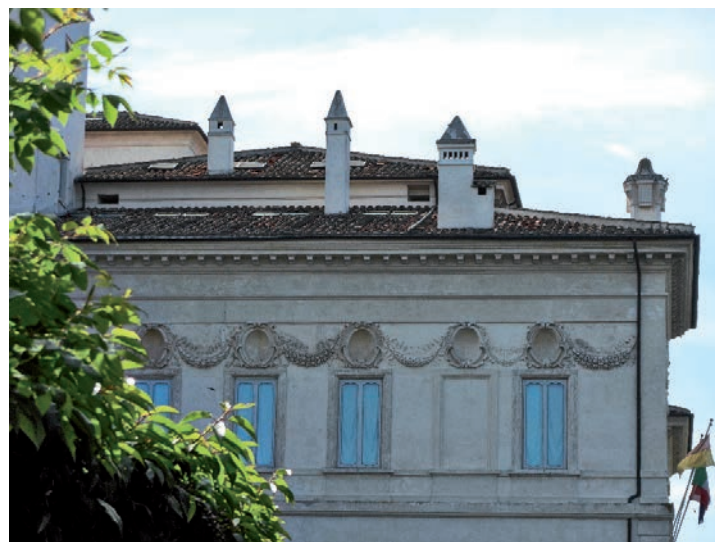
Figura 11 – Vista dei camini su parte della copertura
