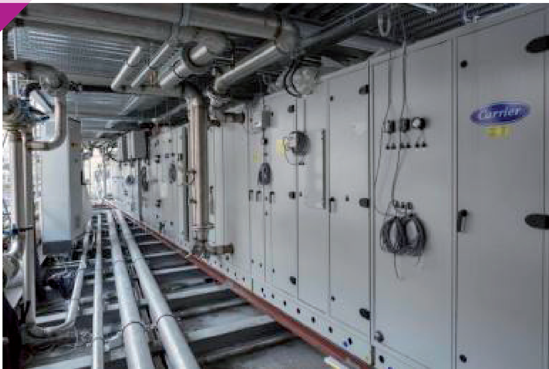
Cappella Sistina, esterno Parti del nuovo impianto di climatizzazione adibite al controllo dei livelli della temperatura e dell'umidità. Foto G. Del Gatto © Governatorato SCV – Direzione dei Musei
