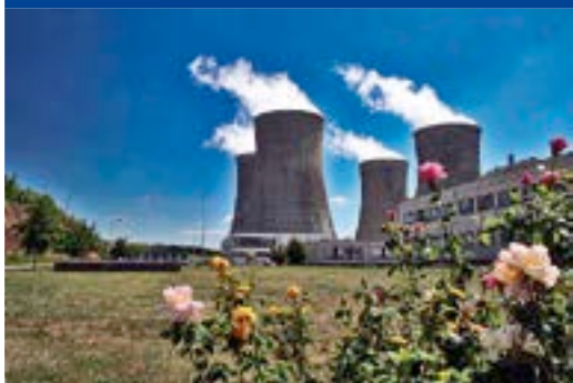
Figura 1 – La centrale termonucleare di Mochovce in Slovacchia [1]
