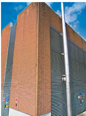
Figura 9 – Superficie della facciata esterna della centrale termica esistente
