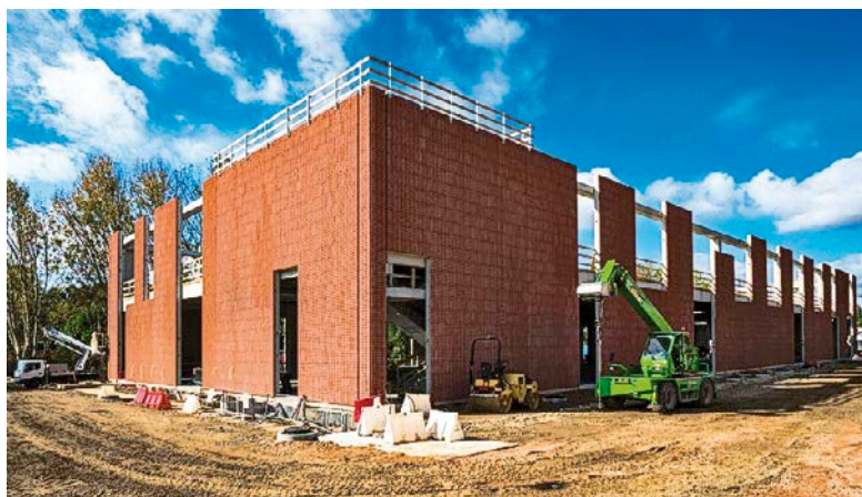
Figura 11 – Nuova centrale in fase di realizzazione
