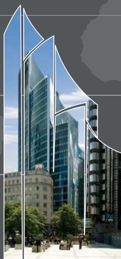
Willis Building Londra - Regno Unito
