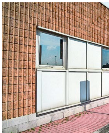
Figura 10 – Facciata dell'edificio area tecnica
