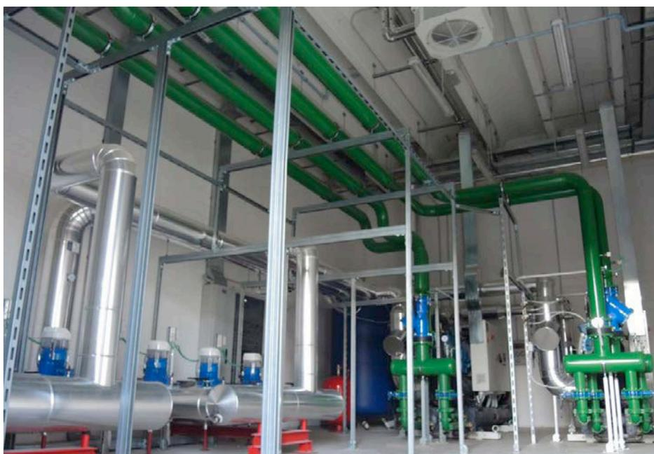
**Figura 5** – Vista della centrale frigorifera, al piano terra dell'edificio 7. In primo piano i collettori con le pompe di circolazione primarie
