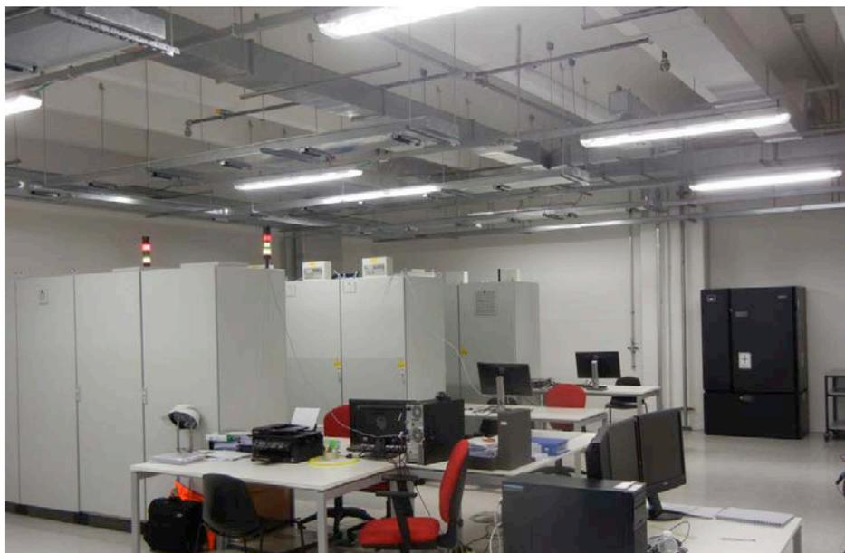
**Figura 4** – Vista di una delle quattro I&C room, dotate di condizionatori di precisione, aria primaria e impianto di spegnimento a gas inerte; si noti l'impiantistica a vista
