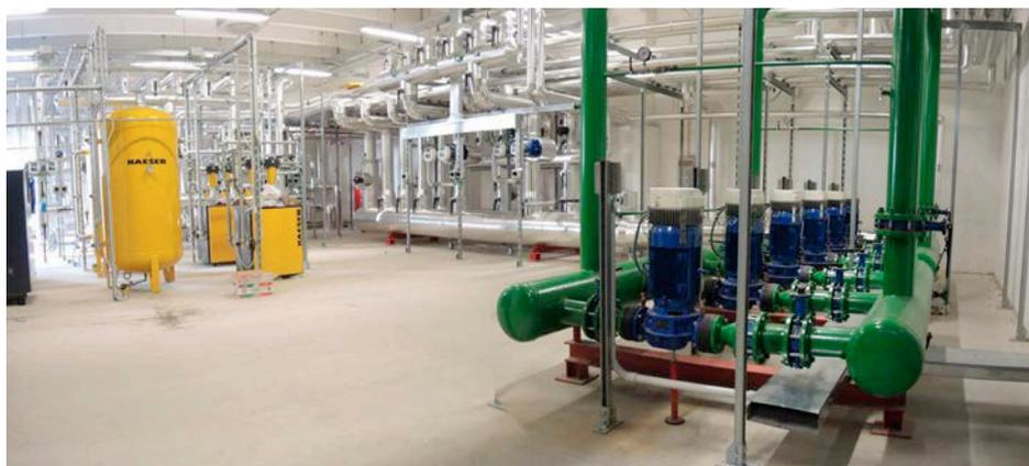
**Figura 7** – Vista della sottocentrale e della centrale di produzione dell'aria compressa, al primo piano dell'edificio 7. In primo piano i collettori di acqua di torre, sullo sfondo a destra i vari circuiti secondari con le pompe di circolazione
