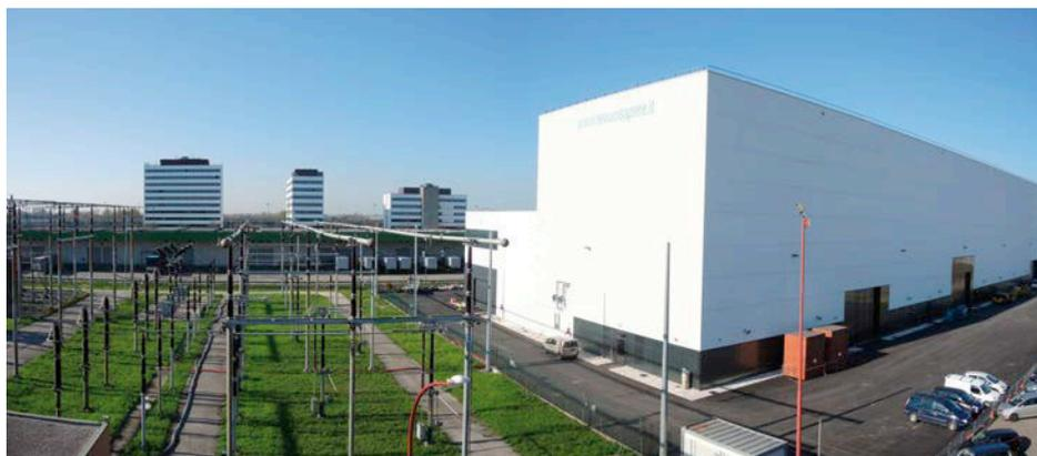
**Figura 1** – Vista panoramica del complesso: in primo piano la parte Est dell'edificio 1, che ospita gli esperimenti MITICA e SPIDER. A sinistra la cabina primaria a 400 kV di alimentazione degli esperimenti SPIDER e MITICA e dell'esperimento RFX-mod in corso da un ventennio
