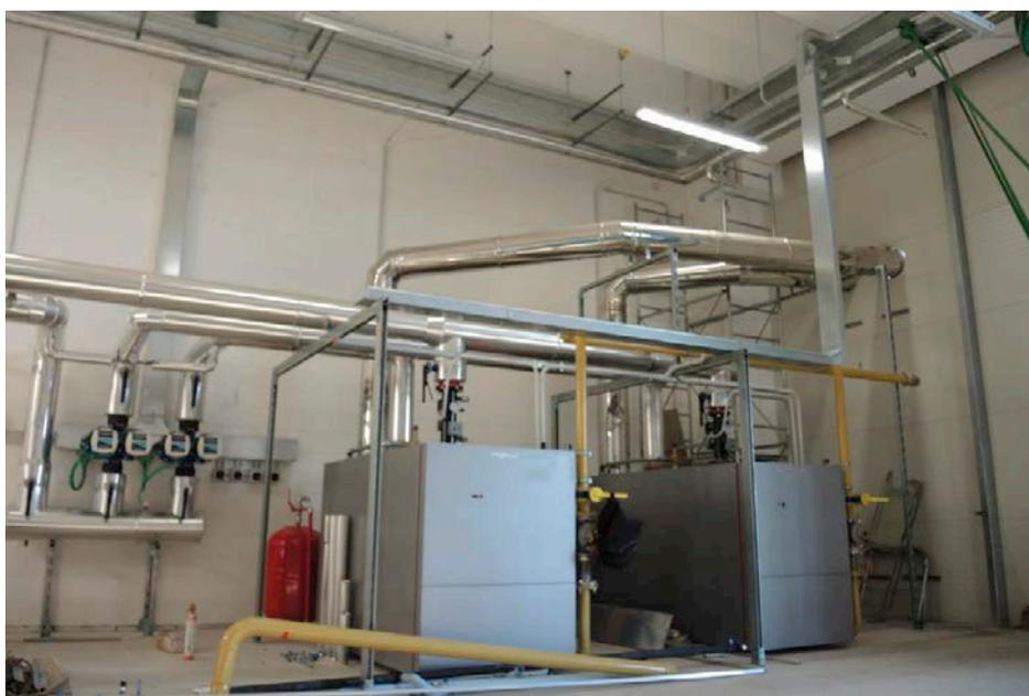
**Figura 6** – Vista della centrale termica, al piano terra dell'edificio 7. In questo locale è ubicata anche la centrale idrica con serbatoio di accumulo, autoclave e sistema di trattamento delle acque per i vari circuiti
