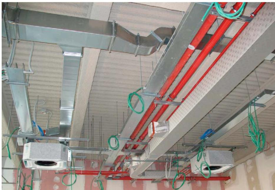
**Figura 9** – Vista di una sala controllo centrale nell'edificio 12, durante la costruzione. Si noti lo sforzo di integrazione dell'impiantistica elettrica e meccanica, reso più complicato dalla necessità di protezione al fuoco del solaio interpieno. Il solaio è metallico, del tipo hi-bond
