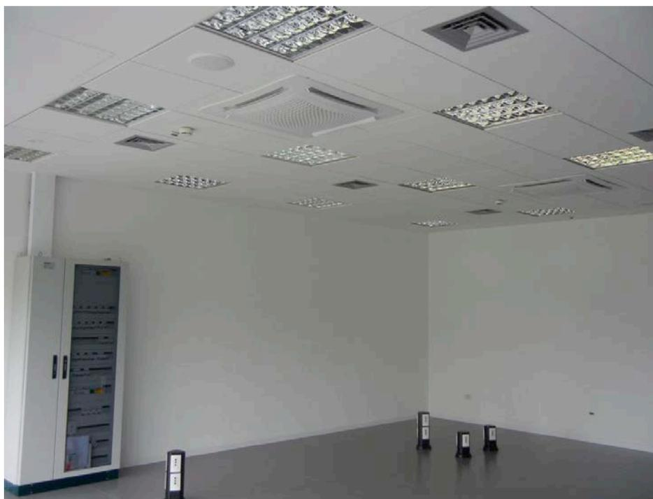
**Figura 10** – Vista di una sala controllo centrale a lavori ultimati. La flessibilità per il futuro arredamento è resa possibile da torrette elettriche integrate nel pavimento flottante, che possono essere spostate secondo le esigenze
