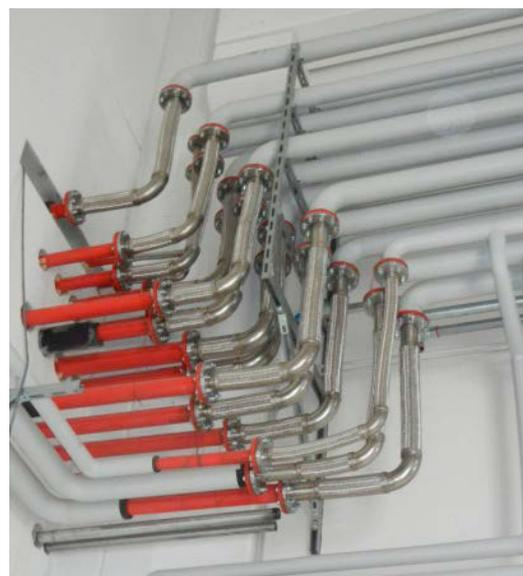
**Figura B** – Giunti flessibili antisismici su tubazioni e canalizzazioni appartenenti a diversi edifici
